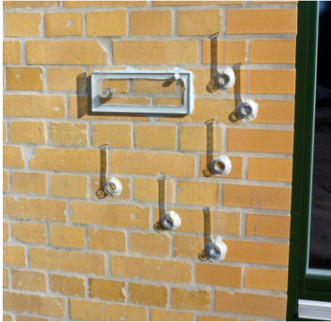
Abbildung. 4: An einem sanierten, denkmalgeschützten Gebäude in Leipzig wurde das WAM mit etablierten In-Situ-Prüfmethoden verglichen. Das Foto zeigt die Wassereindringprüfer nach Karsten und Franke.
