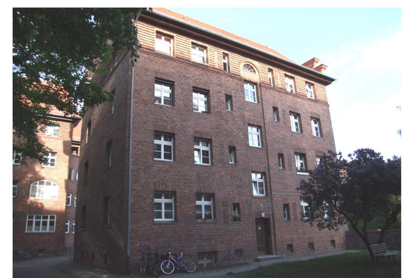
Westansicht des untersuchten Gebäudes
