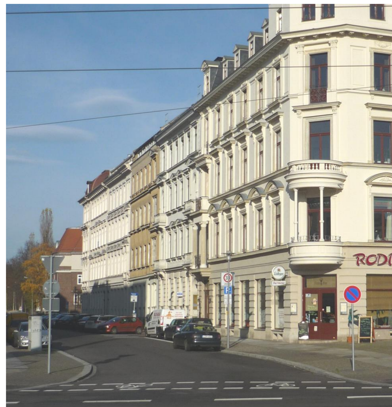
Fassaden unter Denkmalschutz: Eine Dämmung von der Außenseite ist hier nicht möglich
