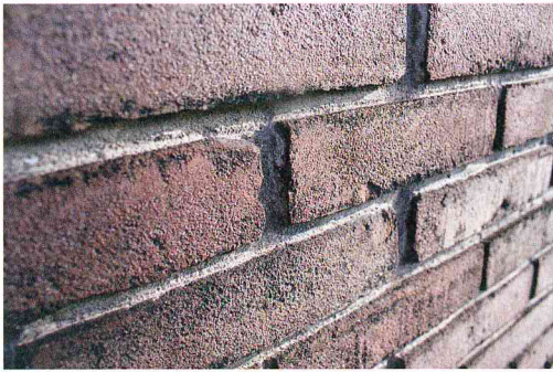
Bild 4. Untersuchte Sichtmauerwerkfassade Objekt 1
